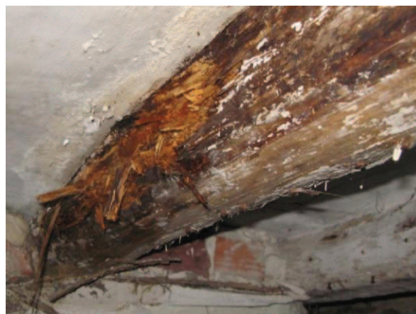
© AIDIMA - Viguetas con degradación causada por hongos xilófagos.
