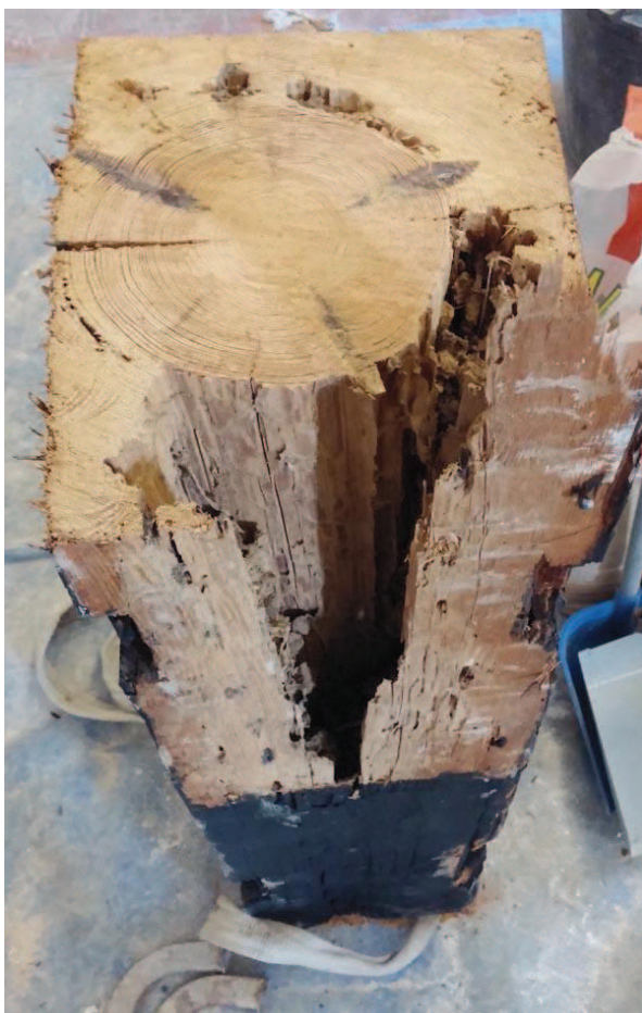
© AIDIMA - Degradación por termitas de una viga en uno de los casos expuestos.
