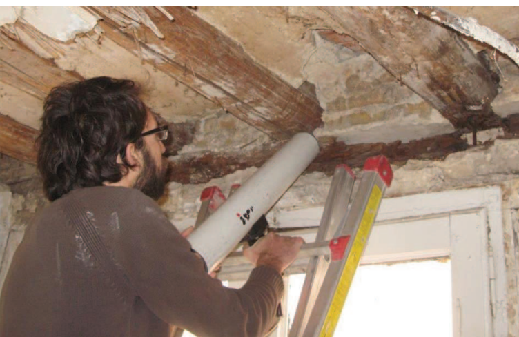
© AIDIMA - Ensayo de resistografía en el empotre de una viga con el muro.
