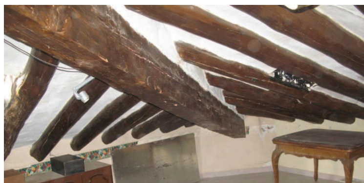
© AIDIMA - Vista general de la viga de carga y las viguetas en una cubierta del edificio.
